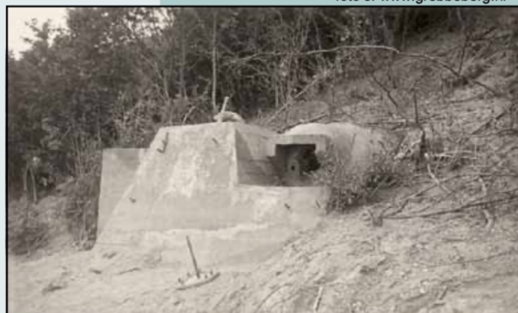
▲ Stellingen in het Hoornwerk ▼ Gietstalen koepelkazemat G2
