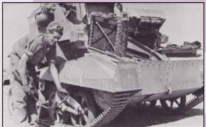
Door het zand, het stof en het intensieve gebruik is goed onderhoud heel belangrijk. Hier is de bestuurder van deze Mk VI bezig de wielen door te smeren.
